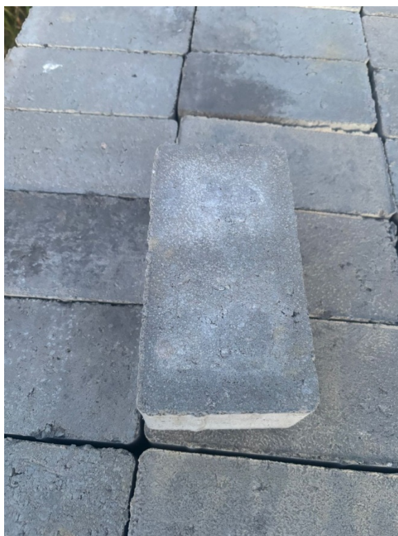
Figura 8: modelo de intertravado de concreto sem chanfro, para facilitar acessibilidade
