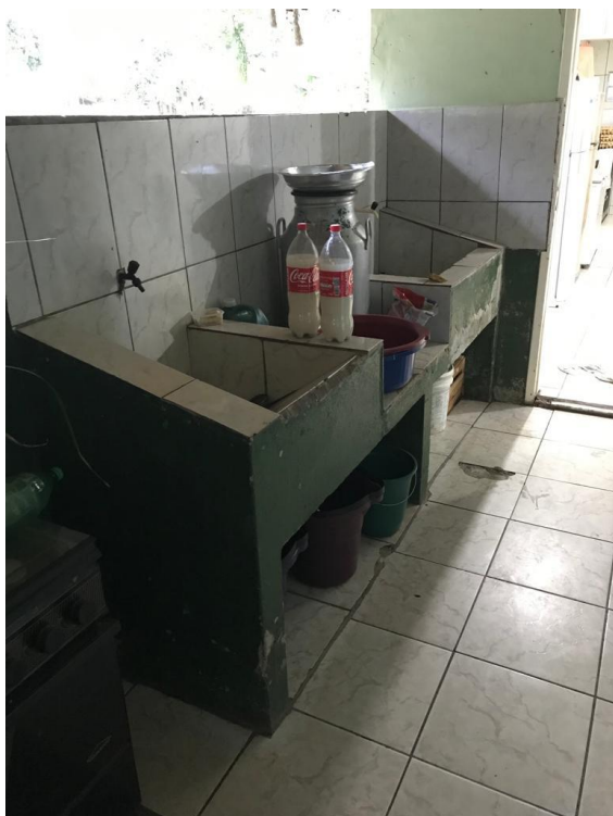
tanque de alvenaria que deverá ser demolido
