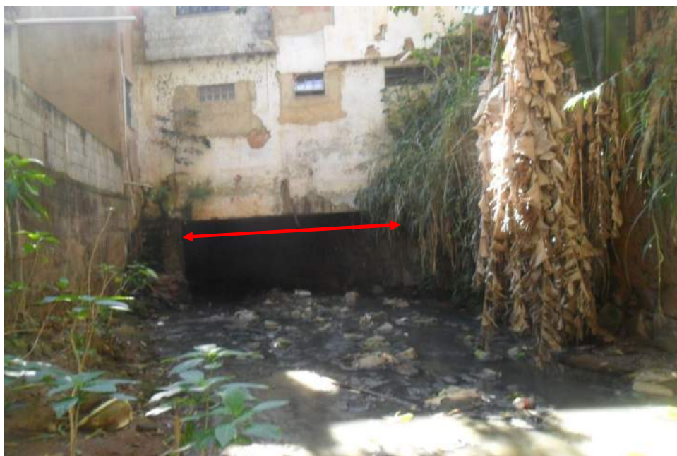
Foto 10: Vista da seção S-4-1 na Travessia 4 (jusante).
