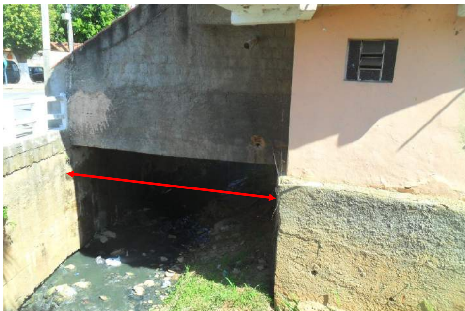
Foto 15: Vista da seção S-6-1 na Travessia 6 (jusante).
