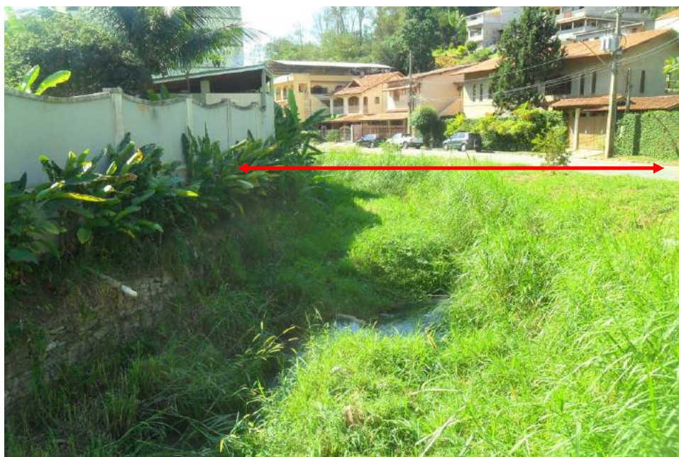
Foto 22: Vista da seção S-8-1 na Travessia 8 (jusante).
