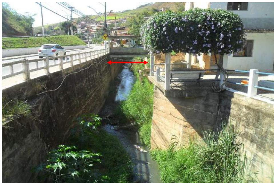
Foto 19: Vista da seção S-7-1 na Travessia 7 (jusante).
