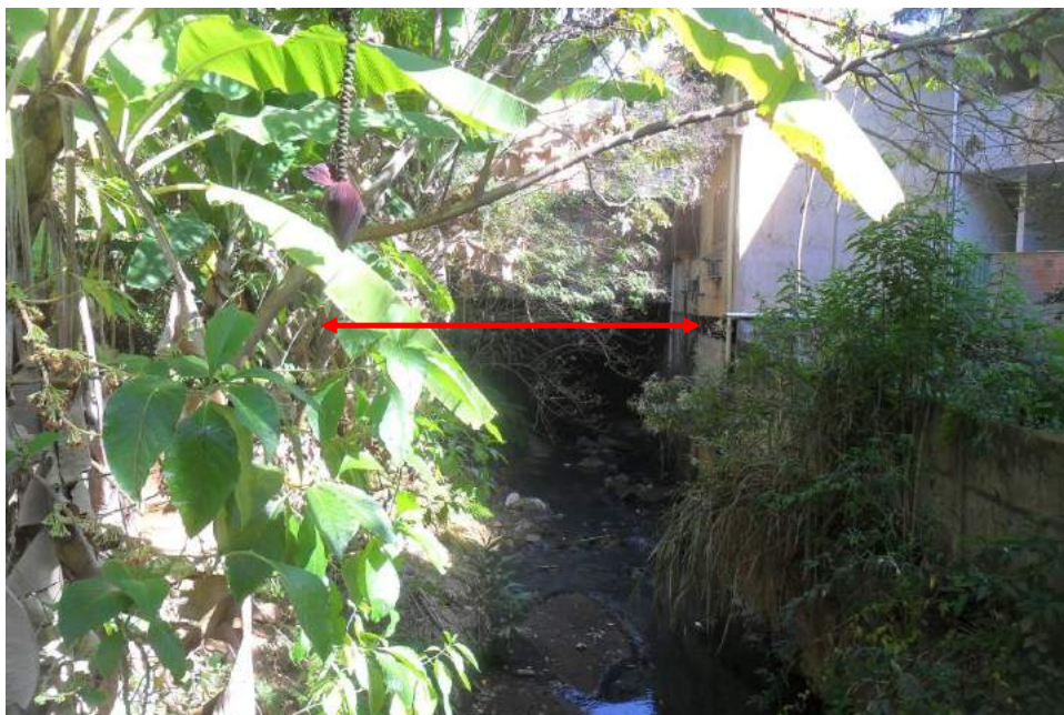
Foto 12: Vista da seção S-4-3 na Travessia 4 (montante).
