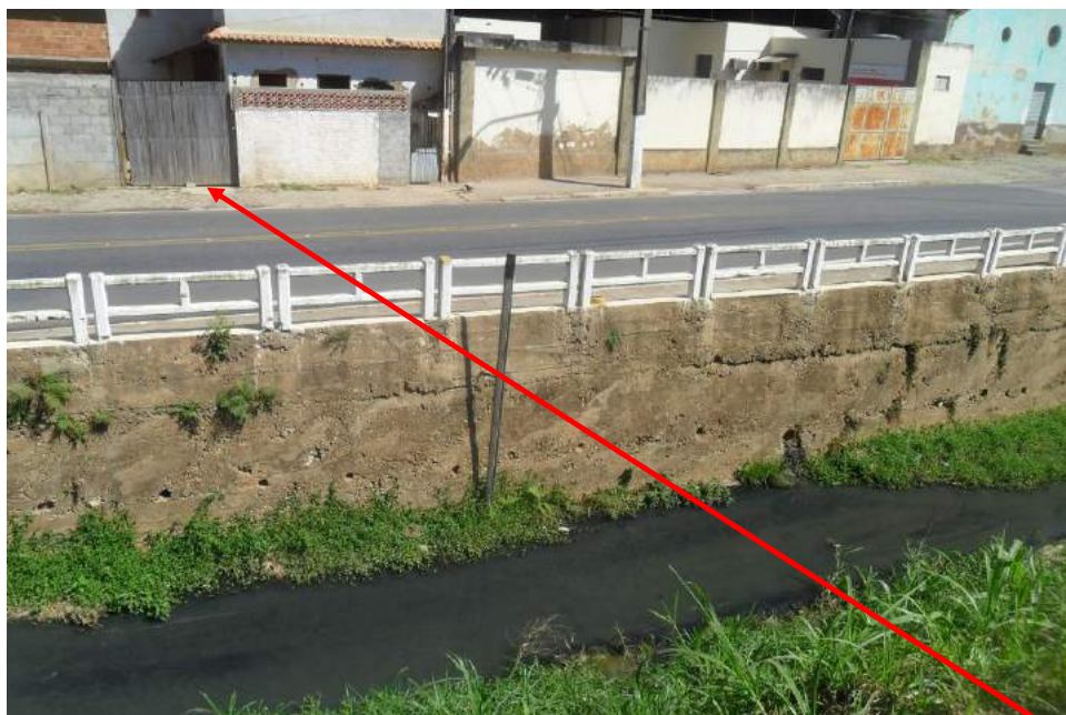
Foto 27: Vista da seção S-9-2 na Travessia 9 (montante).
