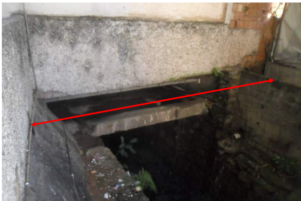
Foto 7: Vista da seção S-3-1 na Travessia 3 (jusante).
