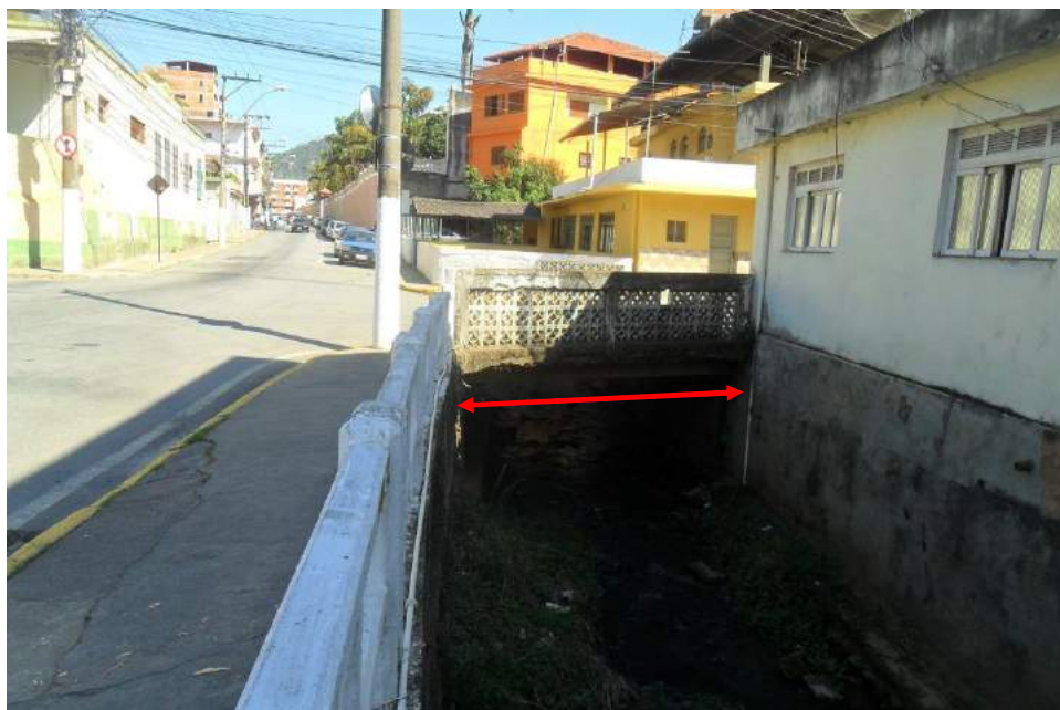
Foto 17: Vista da seção S-6-3 na Travessia 6 (montante).
