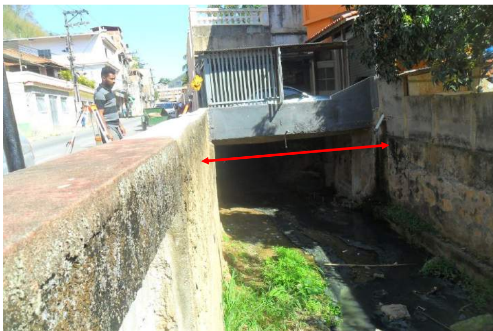
Foto 14: Vista da seção S-5-2 na Travessia 5 (montante).
