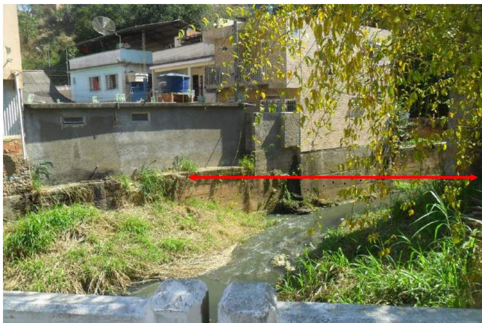
Foto 25: Vista da seção S-9-0 na Travessia 9 (jusante).
