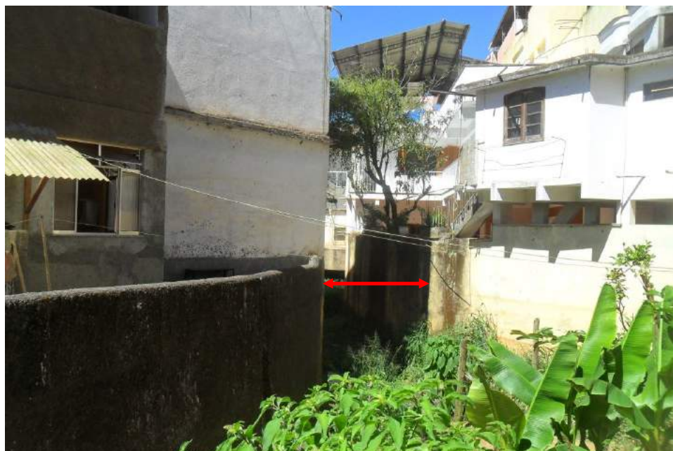
Foto 5: Vista da seção S-2-2 na Travessia 2 (meio).
