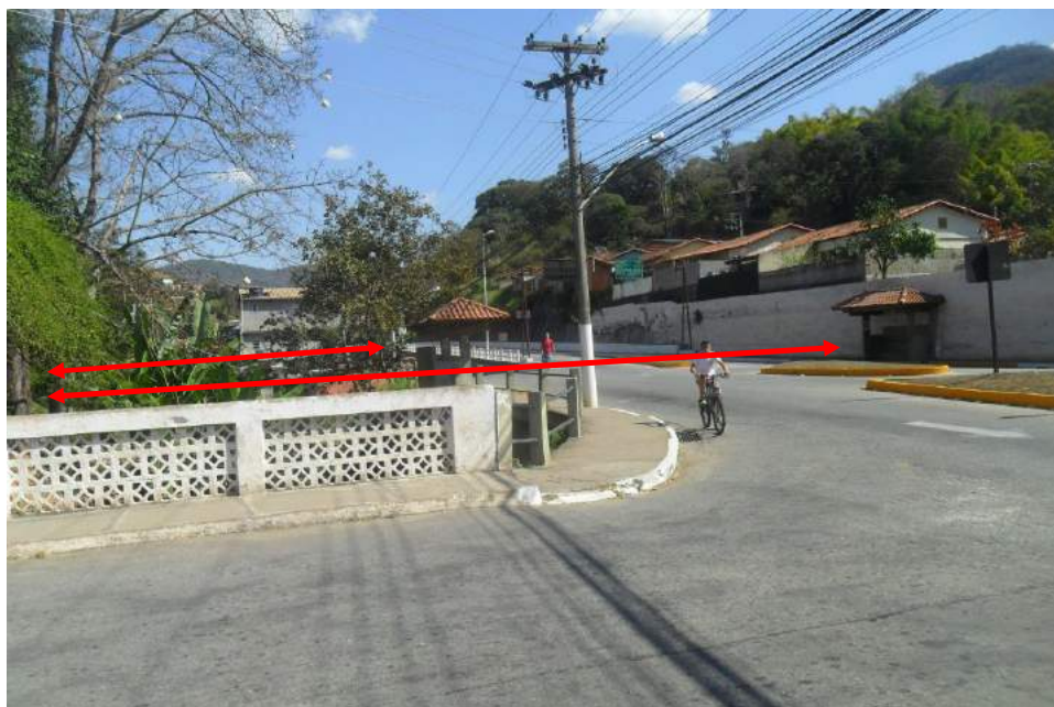
Foto 21: Vista da seção S-7-3 na Travessia 7 (montante).
