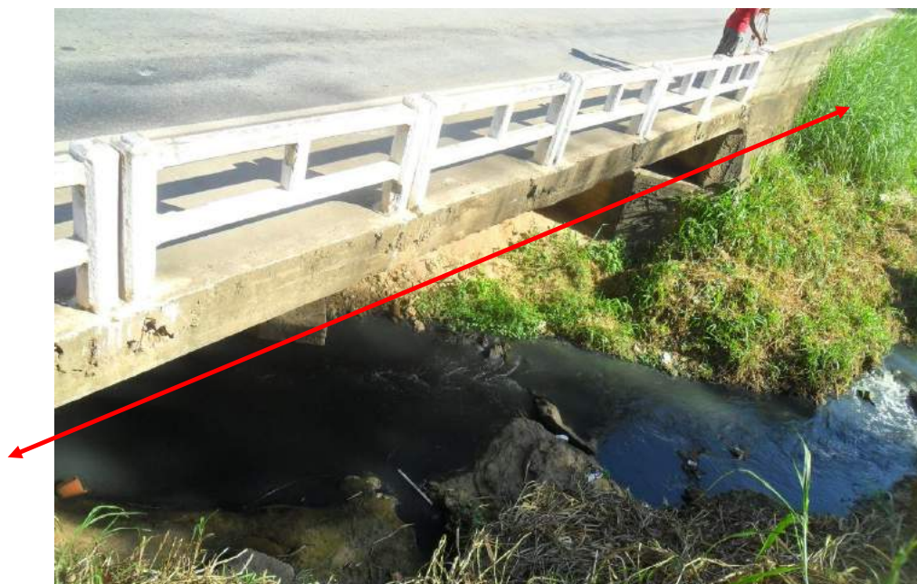
Foto 28: Vista da seção S-10-1 na Travessia 10 (ponte).
