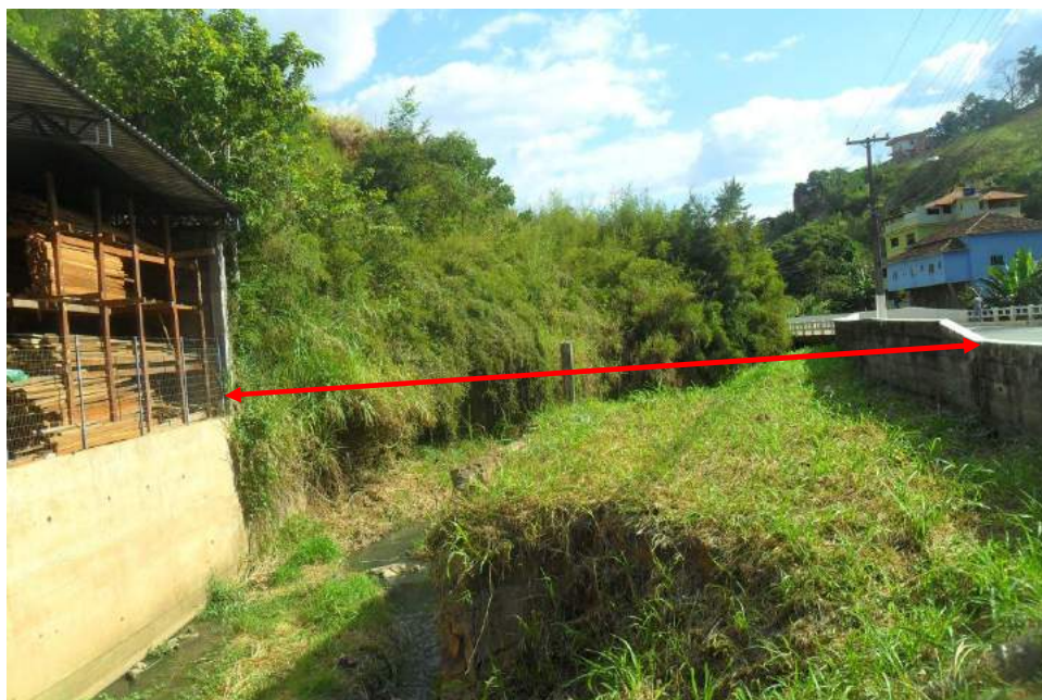
Foto 33: Vista da seção S-11-3 na Travessia 11 (montante).
