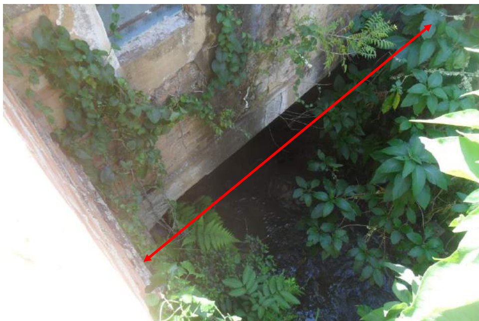
Foto 9: Vista da seção S-3-3 na Travessia 3 (montante).
