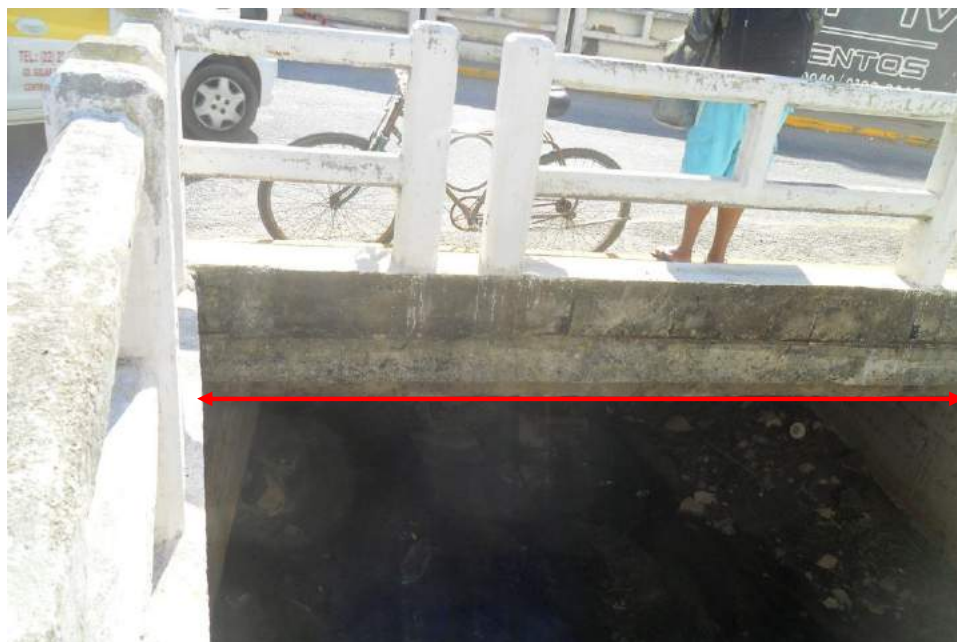
Foto 1: Vista da seção S-1-1 na Travessia 1 (jusante).
