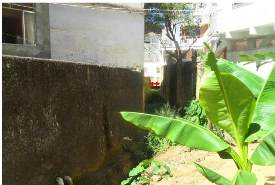
Foto 4: Vista da seção S-2-1 na Travessia 2 (jusante).
