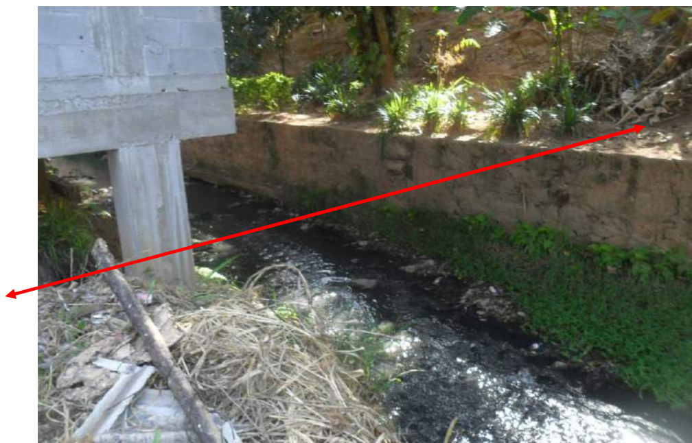
Foto 30: Vista das seções S-10-3 na Travessia 10 (montante).
