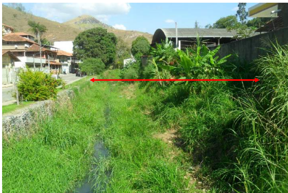
Foto 24: Vista da seção S-8-3 na Travessia 8 (montante).
