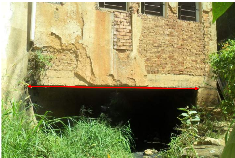
Foto 6: Vista da seção S-2-3 na Travessia 2 (montante).
