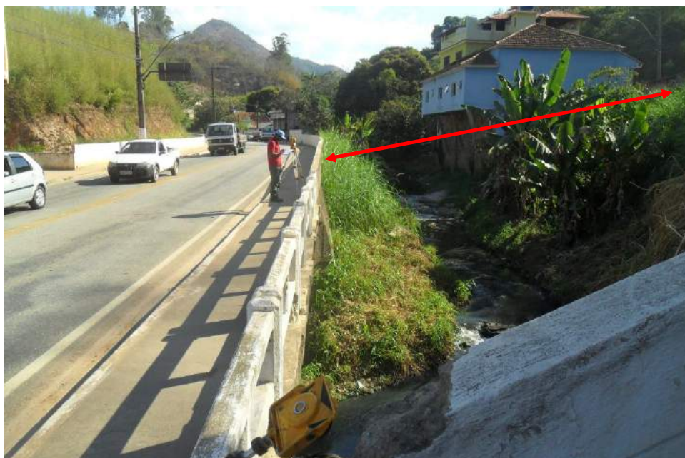
Foto 29: Vista das seções S-10-2 na Travessia 10 (montante).
