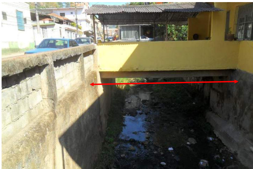
Foto 13: Vista da seção S-5-1 na Travessia 5 (jusante).
