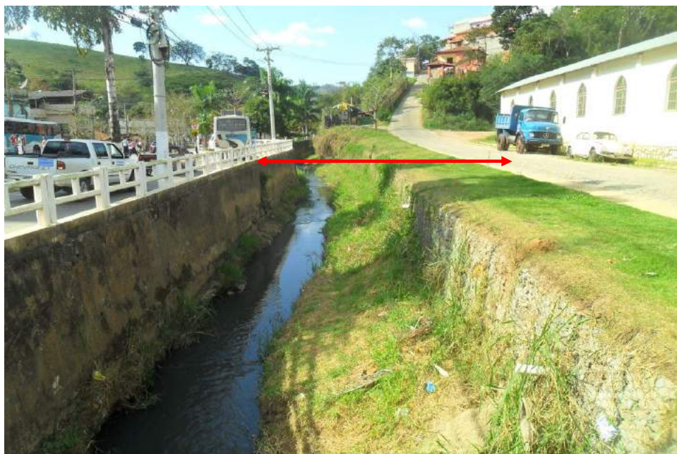
Foto 31: Vista da seção S-11-1 na Travessia 11 (jusante).
