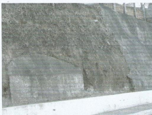
Talude sobre passeio público.
