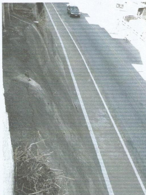
Revestimento com manta de cimento magro no talude sob o imóvel ao lado.
