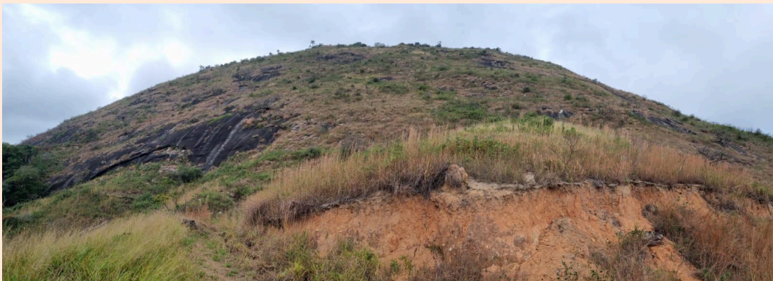
Imagem 2. Entorno da área da unidade de conservação a ser criada na Chácara da Banheira com destaque para o maciço rochoso e o limite Sul/Sudeste da futura unidade
